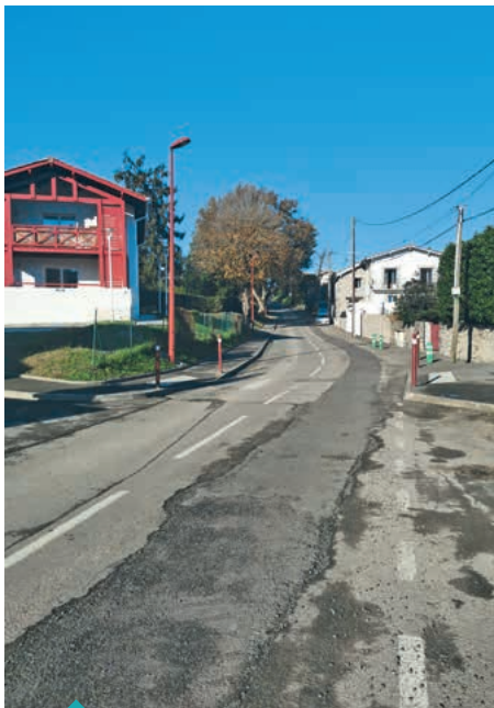
Réfection des adductions d'eau potable rue Bouvet de Thèze Ur ekarteen berritzea Bouvet de Thèze karrikan En fin d'année, la communauté d'agglomération Pays Basque a effectué des travaux sur l'adduction d'eau potable, rue Pierre Bouvet de Thèze, pour améliorer le rendement du réseau.
